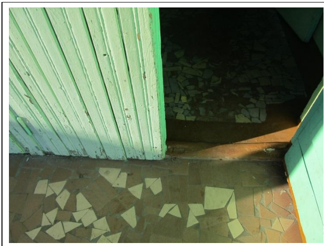
Фото 7 Входная дверь внешняя.
