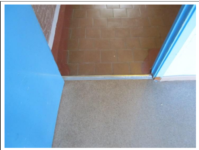
Фото 28 Санитарный узел (дверь)
